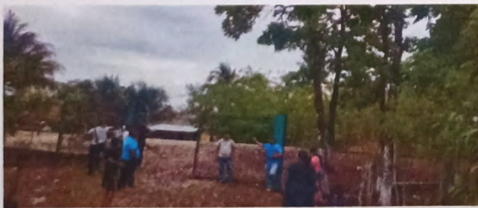
Foto 5: Porton en mal estado.
